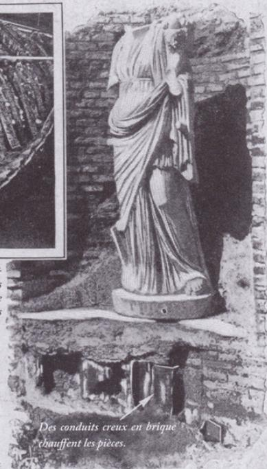
*Des conduits creux en brique chauffent les pièces.*
